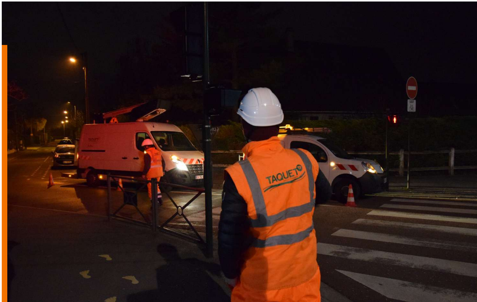
Intervention d'urgence sur le réseau des points lumineux de la ville de Poissy.
