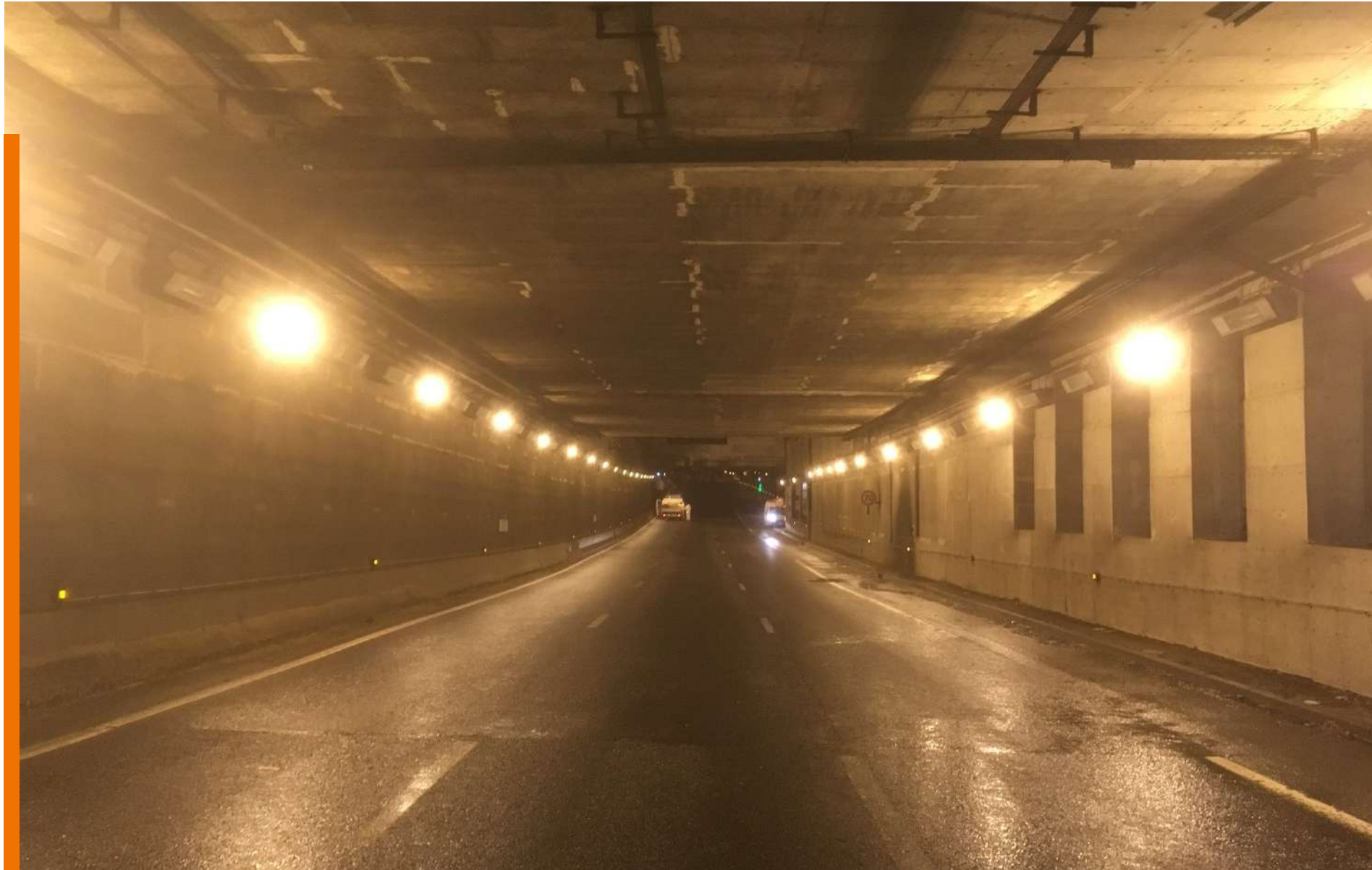
Entretien et modernisation d'un tunnel de la DIRIF.
